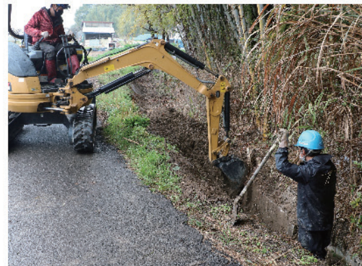
側溝メンテナンス
