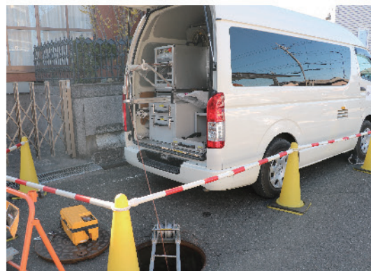
下水道管カメラ調査
