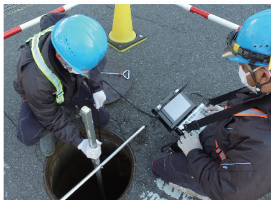
下水道管口調査
