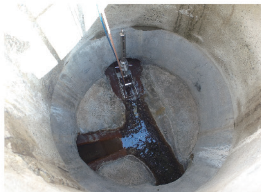
下水道管調査
